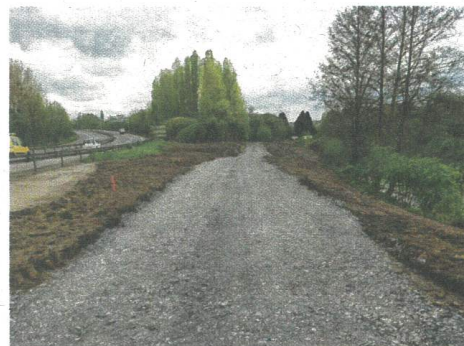
Le chantier est visible depuis la rocade.
