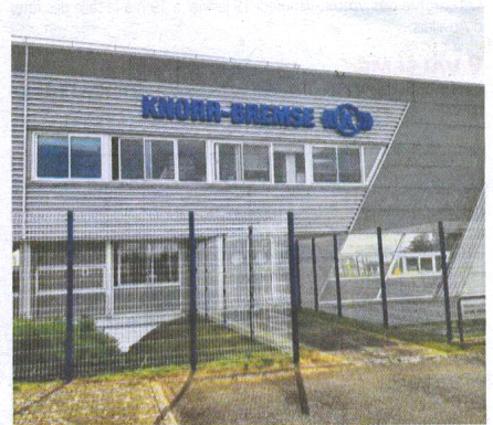
Le site est installé à Glos depuis 1993.
