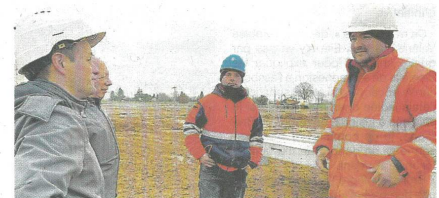
Réunion de chantier en présence de Frédéric Durand, responsable du bureau d'études de la Scam (premier à gauche).
